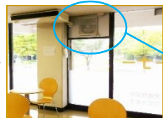
換気扇設置後(8月撮影)
