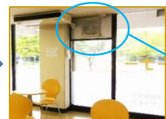
換気扇設置後(8月撮影)
